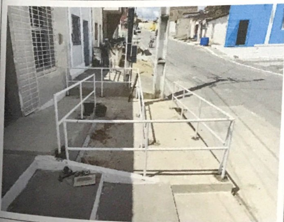
FOTO 5: EXECUÇÃO DA RAMPA DE ACESSIBILIDADE;
